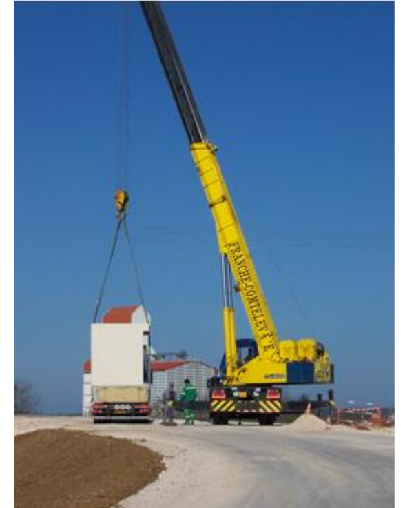
Livraison d'un nouveau poste de transformation
